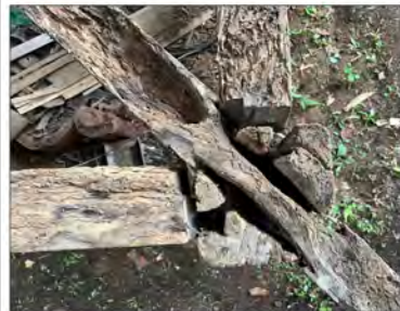
左側後角、木材の傷みが激しい ↑左側後角 ↑縁側の板を外したところ ↑正面左角 ↑土台の柱、老朽化が進んでいる
