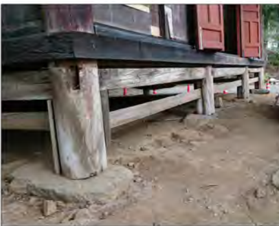
左側後角、木材の傷みが激しい ↑左側後角 ↑縁側の板を外したところ ↑正面左角 ↑土台の柱、老朽化が進んでいる
