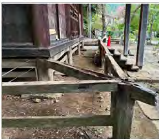
左側後角、木材の傷みが激しい ↑左側後角 ↑縁側の板を外したところ ↑正面左角 ↑土台の柱、老朽化が進んでいる
