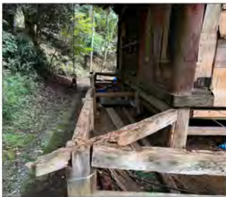
左側後角、木材の傷みが激しい ↑左側後角 ↑縁側の板を外したところ ↑正面左角 ↑土台の柱、老朽化が進んでいる
