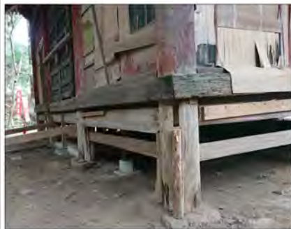
左側後角、木材の傷みが激しい ↑左側後角 ↑縁側の板を外したところ ↑正面左角 ↑土台の柱、老朽化が進んでいる
