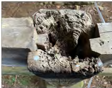
左側後角、木材の傷みが激しい ↑左側後角 ↑縁側の板を外したところ ↑正面左角 ↑土台の柱、老朽化が進んでいる
