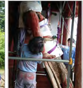
クレーンで吊り上げる
