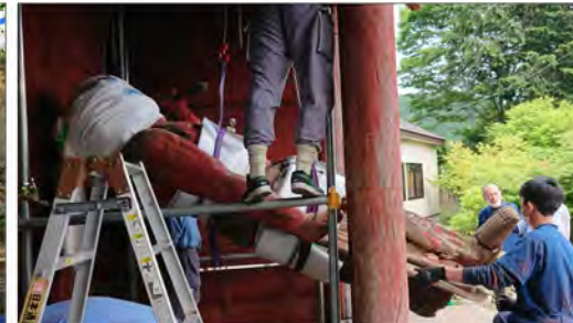
クレーンを操作しながら、前方へ出して行く
